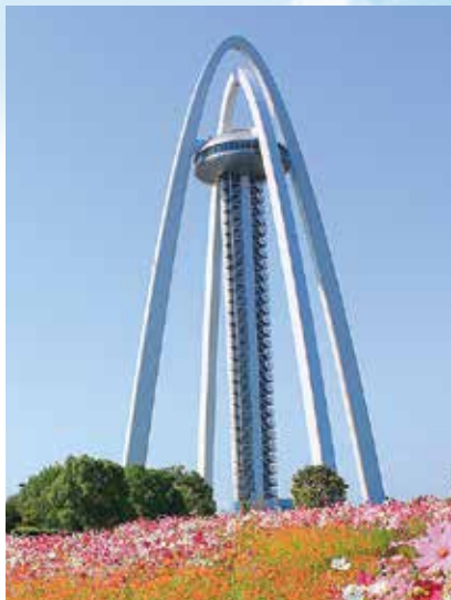
双曲拱138 Twin Arch 138
